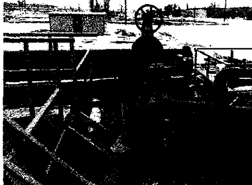
Реконструкция аэротенков с внедрением современных технологий нитри-денитрификации – I этап (аэротенки №3, №4)
